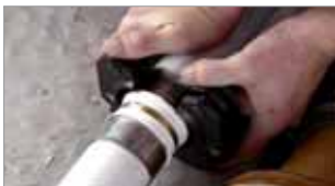
Anlegen der Pressschlinge
